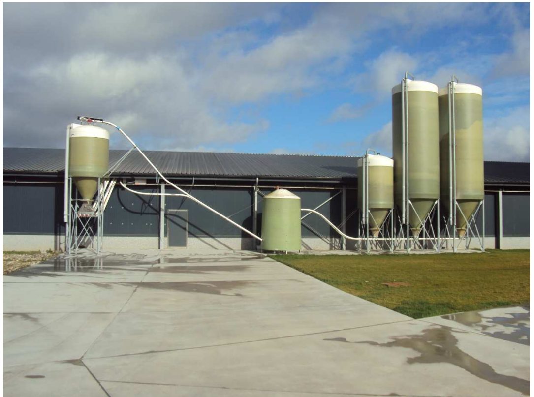
Accès aux cellules coté Ouest. Source CERFRANCE 5962
