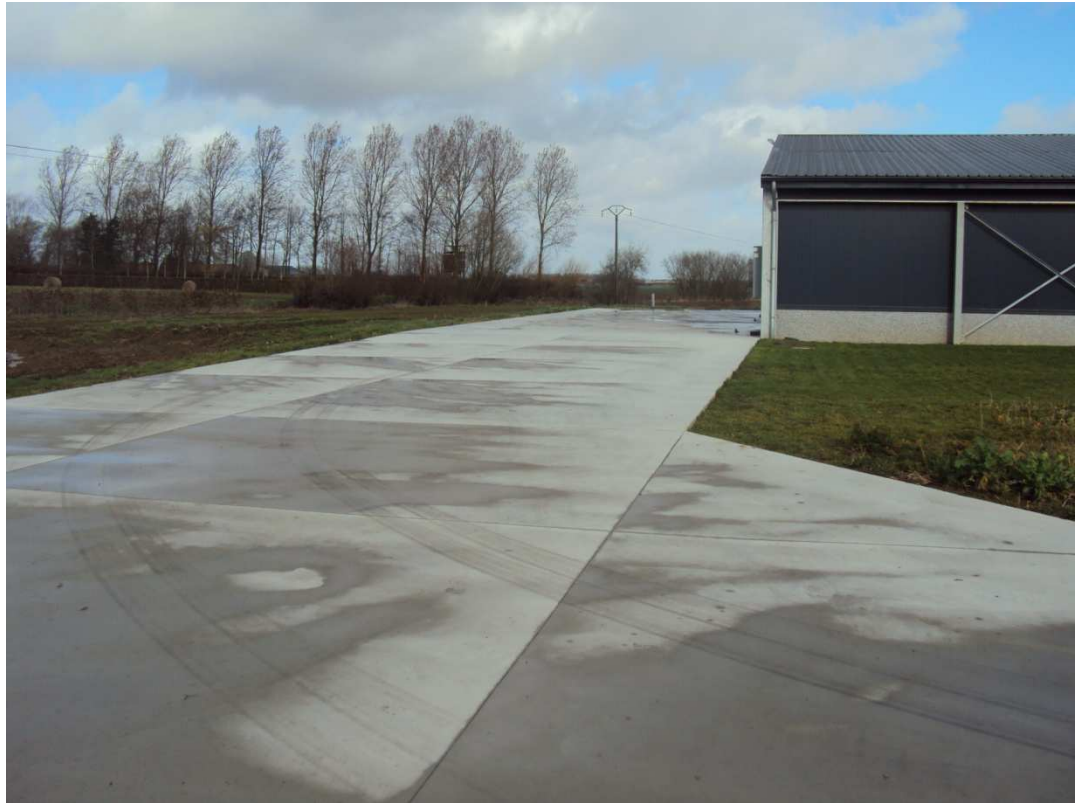
Aire de manœuvre pignon Nord. Source CERFRANCE 5962
