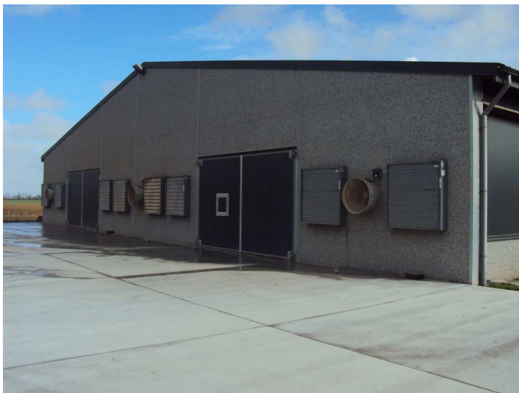
Sortie des extracteurs d'air. Pignon nord. Source CERFRANCE 5962.
