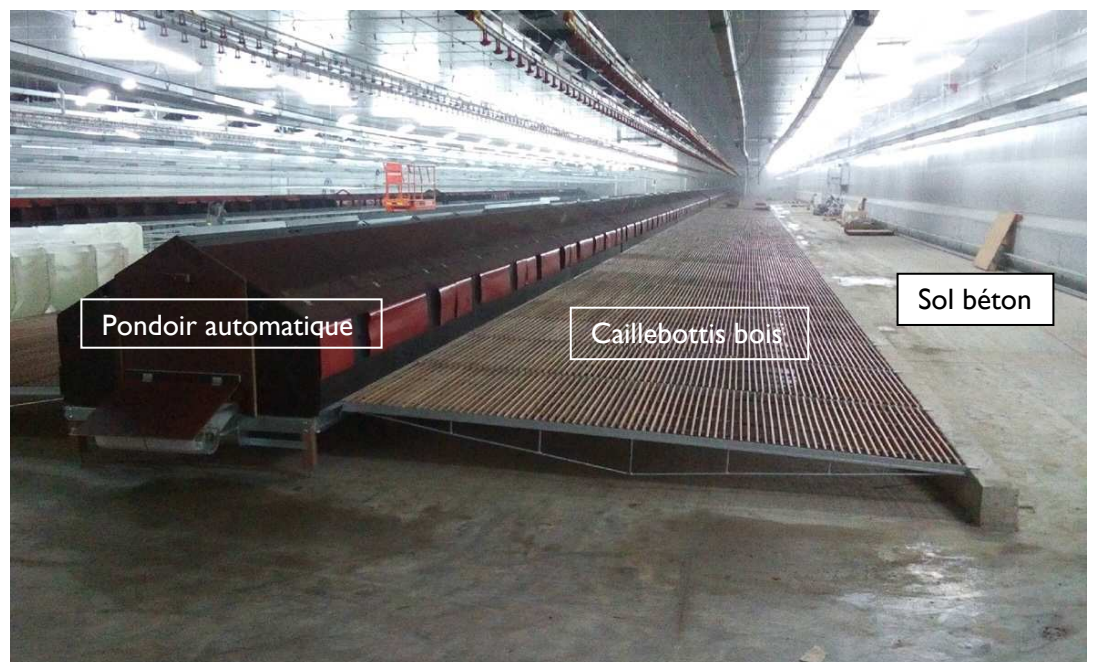
Répartition des espaces de vie, bâtiment vide. Source JL DEMOL
